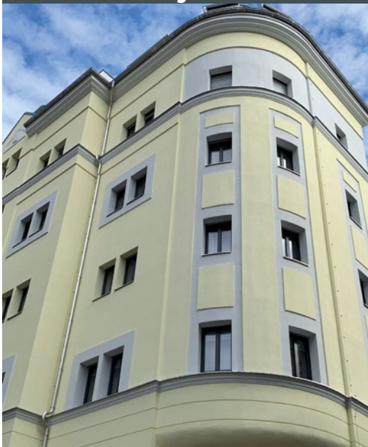
Das Gründerzeithaus in der Canisiusgasse wurde mit Mineralfaser-Fassadenplatten gedämmt.
